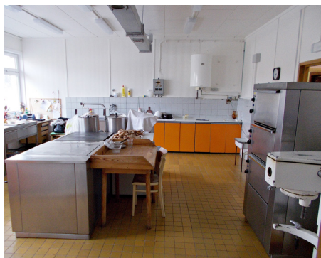
Kuchyně v MŠ před rekonstrukcí
